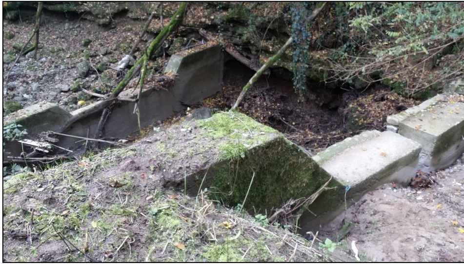
Figura 26: Briglia a valle dell'attraversamento di via della Valle (Calò)
