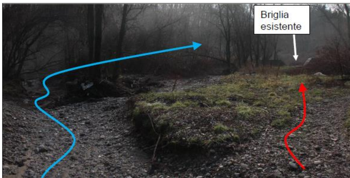
Figura 53: situazione inerente la briglia aggirata-vista da monte verso valle. Freccia Rossa=antico corso del rio; freccia Blu=corso del Rio attuale, accompagnato da una maggiore erosione dell'alveo.
